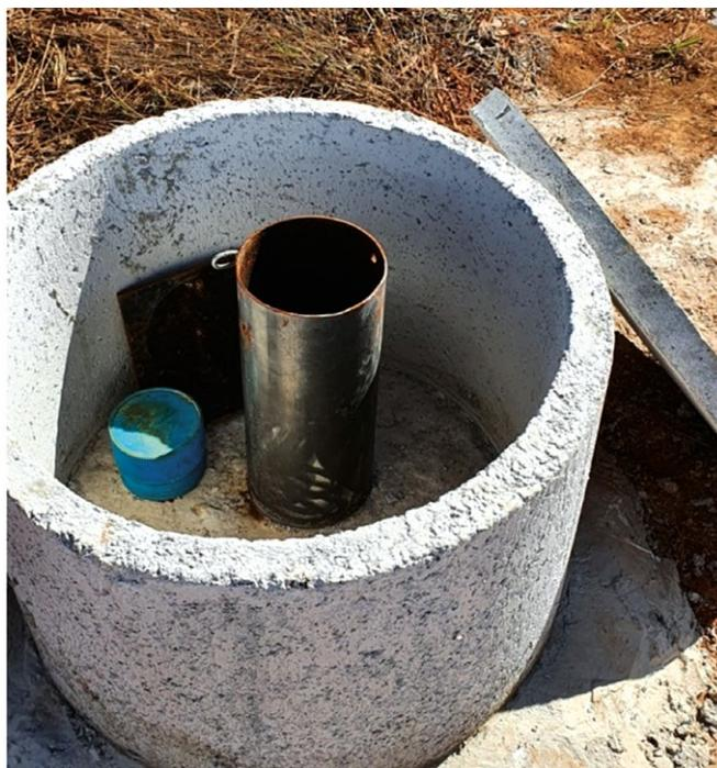
**FIGURA 34** – CERCA DE PROTEÇÃO DE POÇOS INSTALADOS NA ÁREA URBANA DA CIDADE ESTRUTURAL
