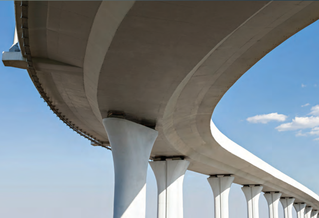
Viaduto construído em concreto
