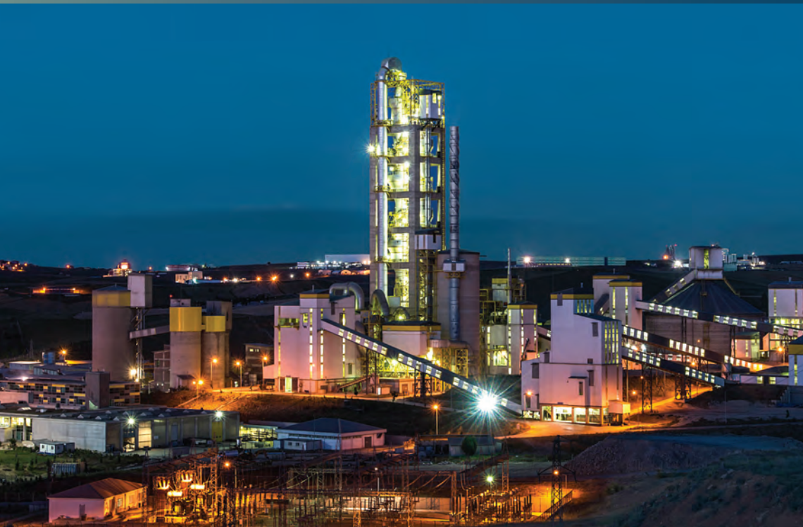
Visão noturna de uma fábrica de cimento
