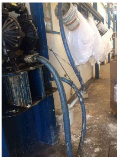
Foto 11. Bombeamento do produto para o misturador.
