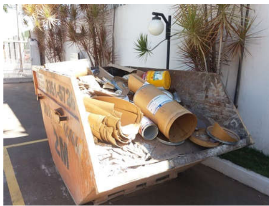
Foto 06. Disposição de resíduos sólidos de forma inadequada (misturados).
