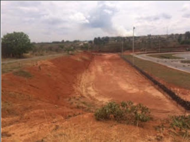
Foto 03. Talude sem cobertura vegetal ou contenção.
