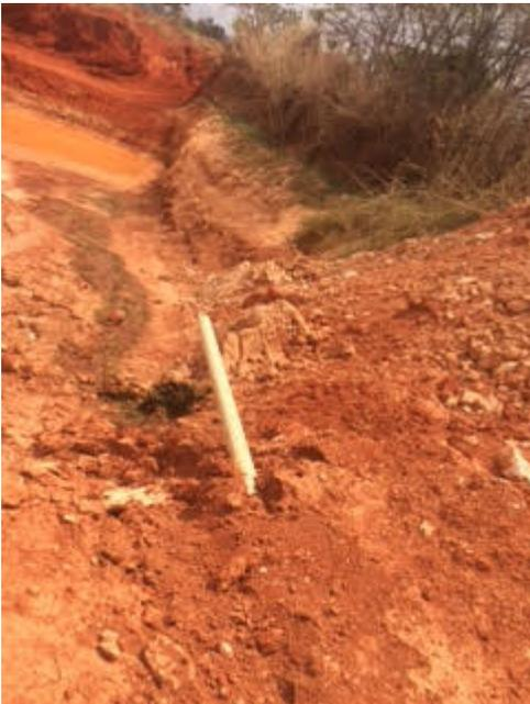
Foto 07. Lançamento da fossa séptica na bacia de contenção.
