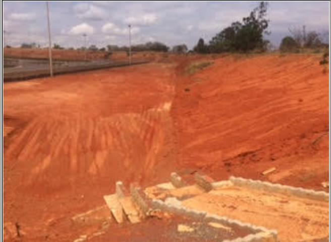
Foto 04. Talude sem cobertura vegetal ou contenção.
