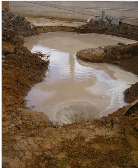
**Figura 10** – Impacto da não observação dos critérios geotécnicos na execução de obras de pavimentação. Fonte: EA Topocart.
