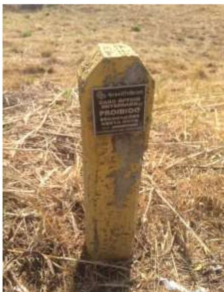
Cabo óptico enterrado ao longo da via
