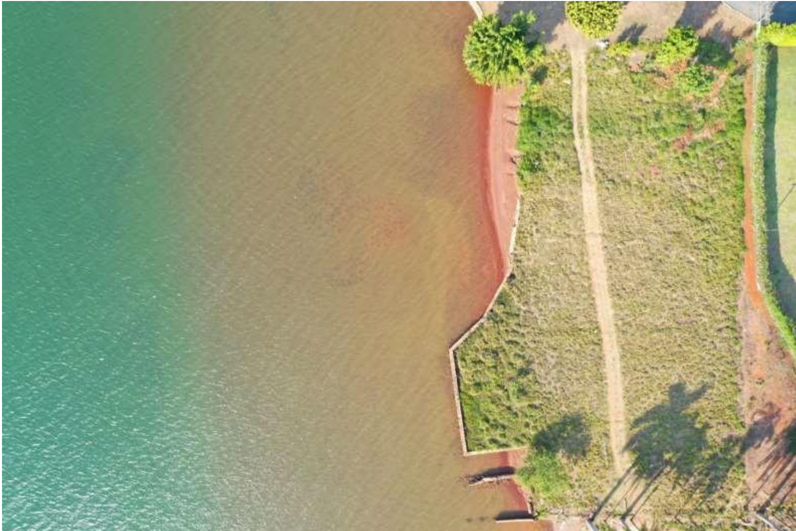
Imagem 10 - Imagem aérea de área em recuperação, Setor de Habitações Individuais Sul QL 26. Ano: 2020.
