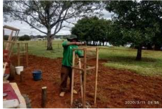
Figura 43 - Protetores de mudas instalados em locais de amplo fluxo de frequentadores.
