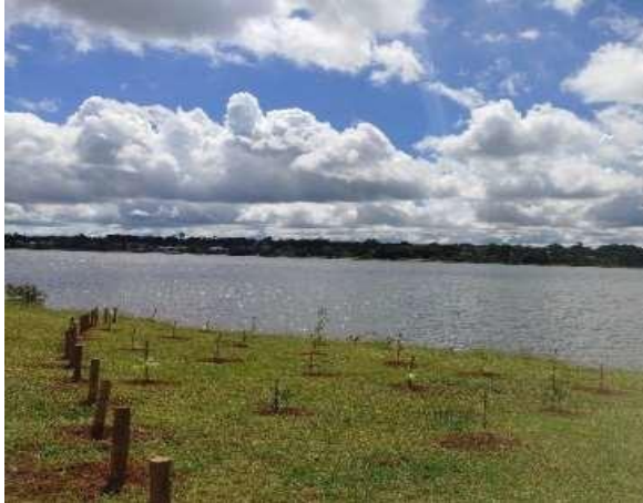
Figura 69 - Instalação de contentores veiculares, às margens do Lago Paranoá,
