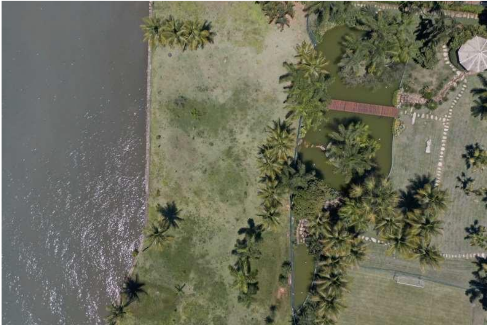
Imagem 39 - Imagem aérea de área em recuperação, Setor de Habitações Individuais Sul QL 08. Ano: 2022.
