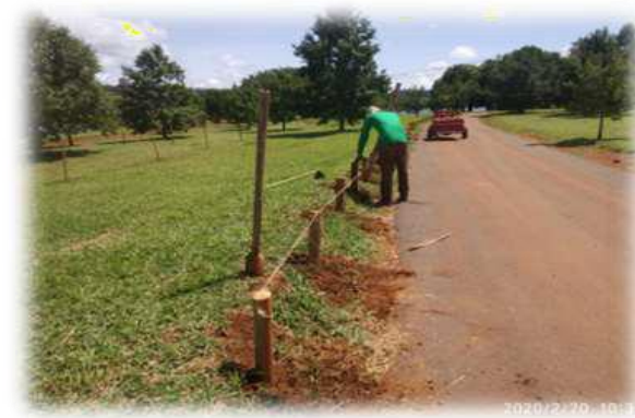
Figura 44 - Instalação de contentores de veículos.
