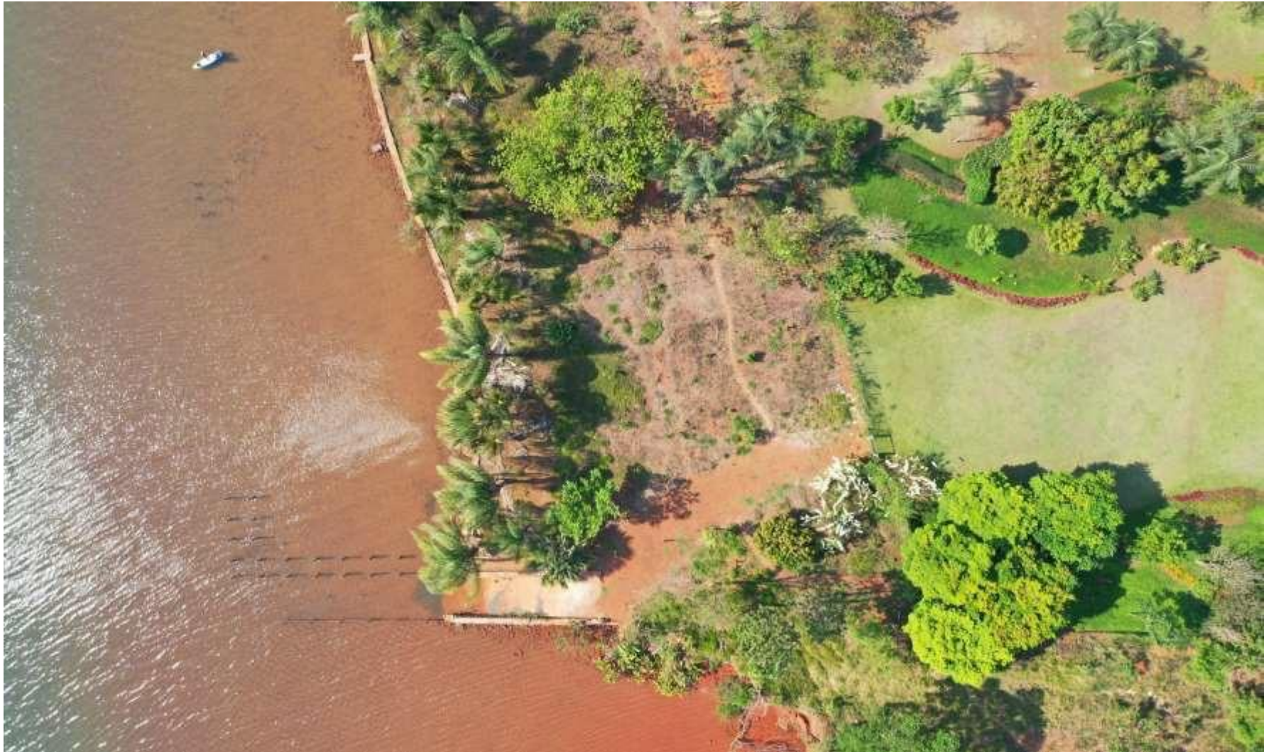
Imagem 1 - Imagem aérea de área em recuperação, Setor de Habitações Individuais Sul QL 28. Ano: 2020.
