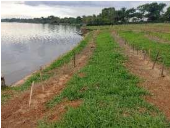
Figura 143 – Técnica de preparo do solo para a sementeira direta na QL 08.
