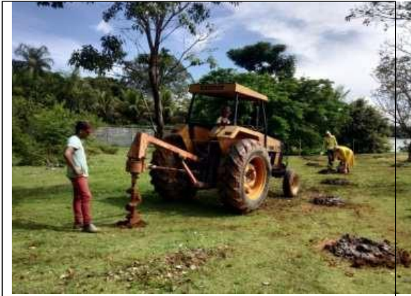
Figura 5- Abertura mecanizada de cova.
