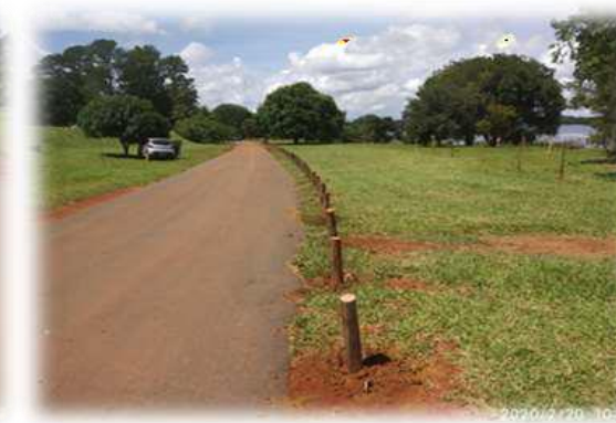
Figura 45 - Instalação de contentores de veículos.
