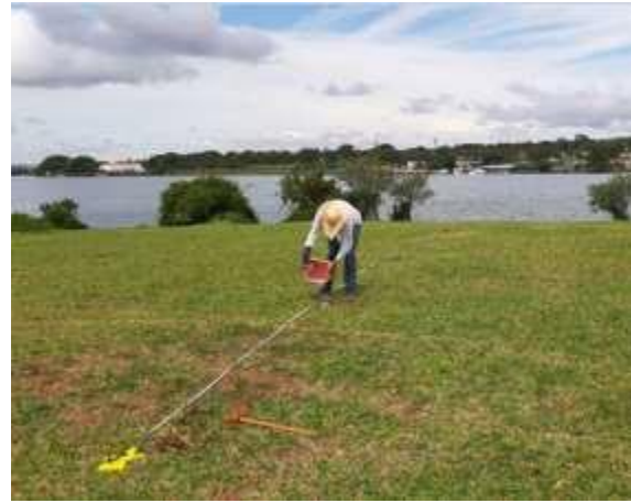
Figura 4- Demarcação dos locais das covas com cal e enxadinha.
