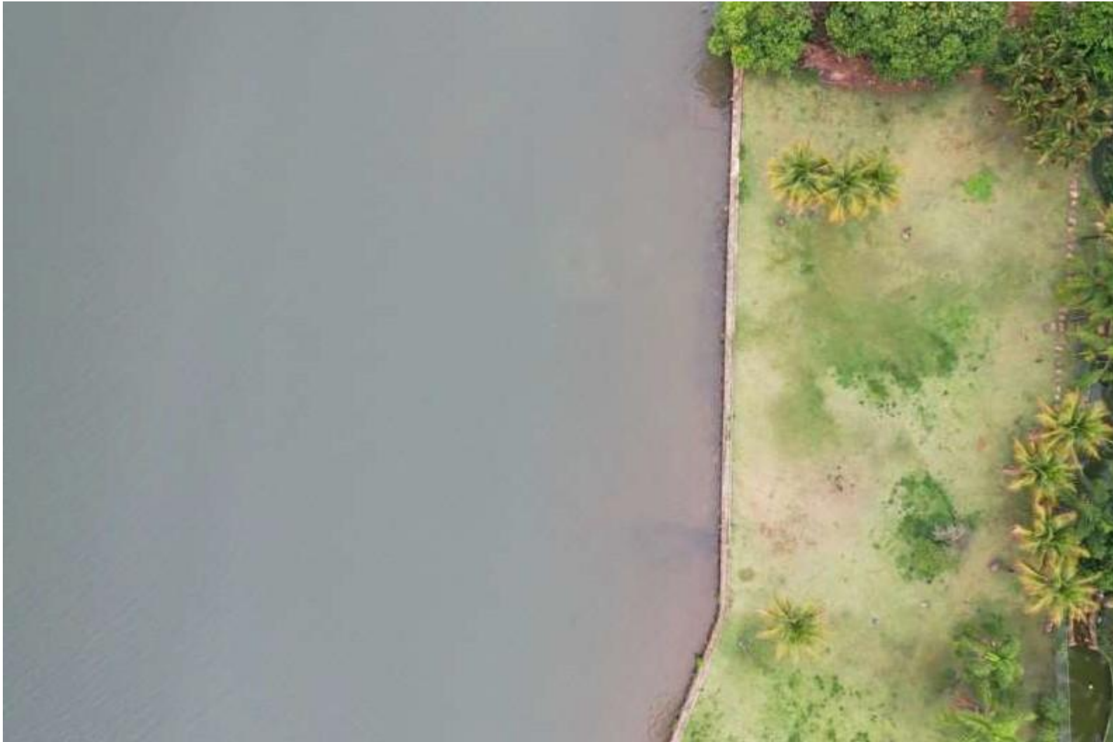
Imagem 36 - Imagem aérea de área em recuperação, Setor de Habitações Individuais Sul QL 08. Ano: 2020.
