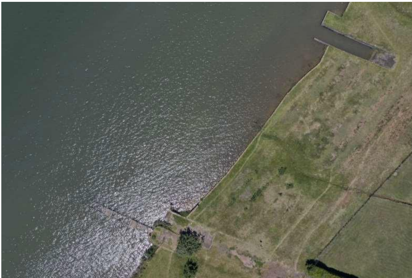
Imagem 38 - Imagem aérea de área em recuperação, Setor de Habitações Individuais Sul QL 08. Ano: 38.
