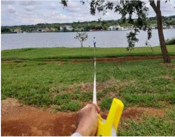
Figura 3- Demarcação da área de APP e delimitação da área de plantio.
