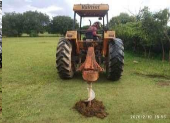
Figura 6- Detalhe do uso de broca perfuratriz para abertura de cova.
