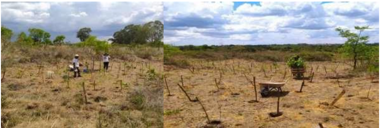
Figura 19 - Estaqueamento de tutores, na ARIE do Riacho Fundo.
