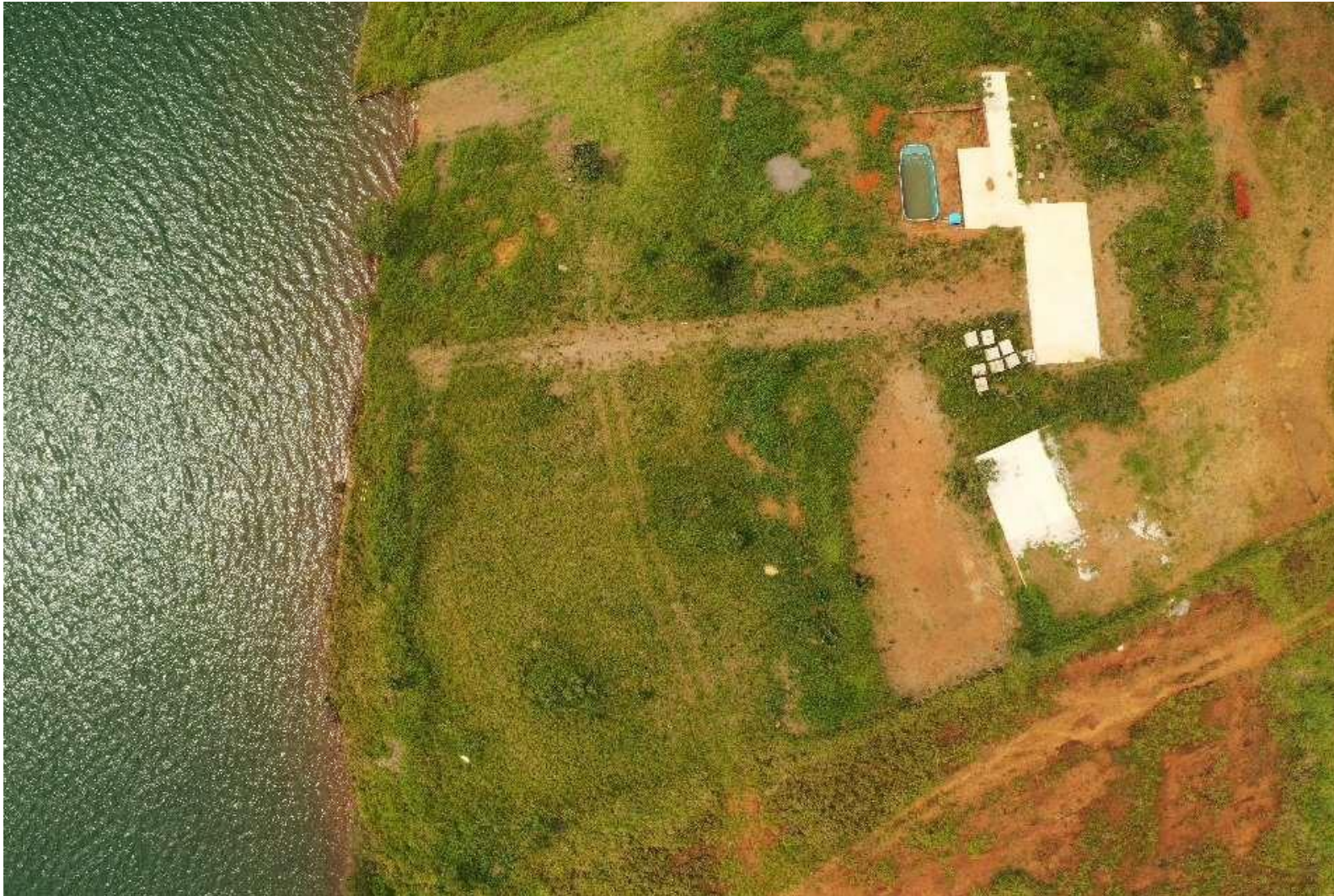
Imagem 22 - Imagem aérea de área em recuperação, no Setor de Habitações Individuais SUL QL 20. Ano: 2020.
